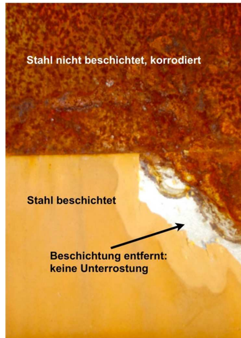
Keine Unterwanderung durch Rost
